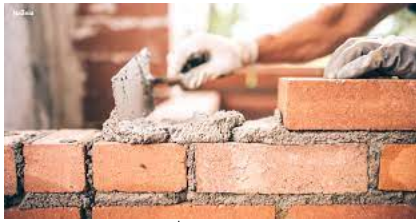
รูปที่ 2.1 การก่ออิฐ
